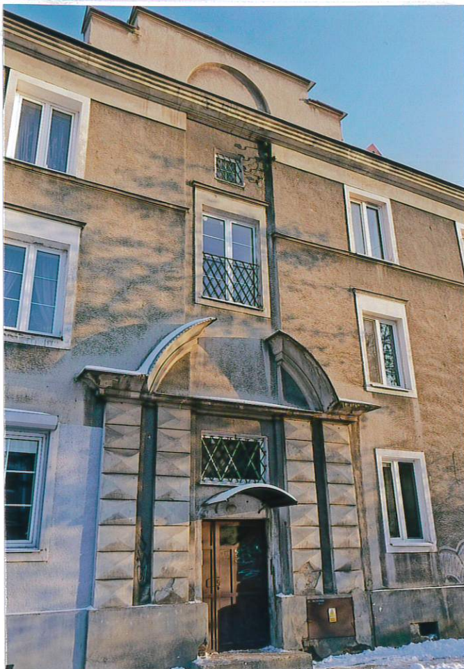
Fot. 3. Ryzalit północny elewacji frontowej.
