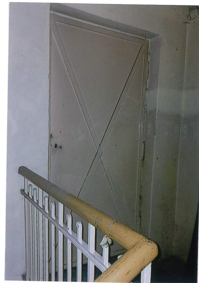
Fot. 12. Drzwi stalowe na poddasze.
