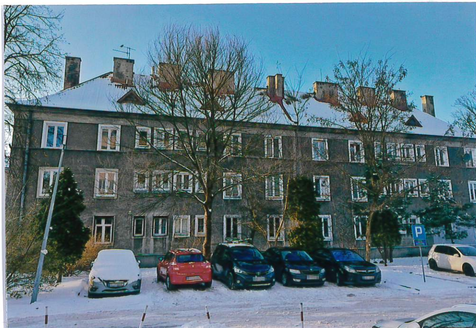
Fot. 8. Elewacja wschodnia.
