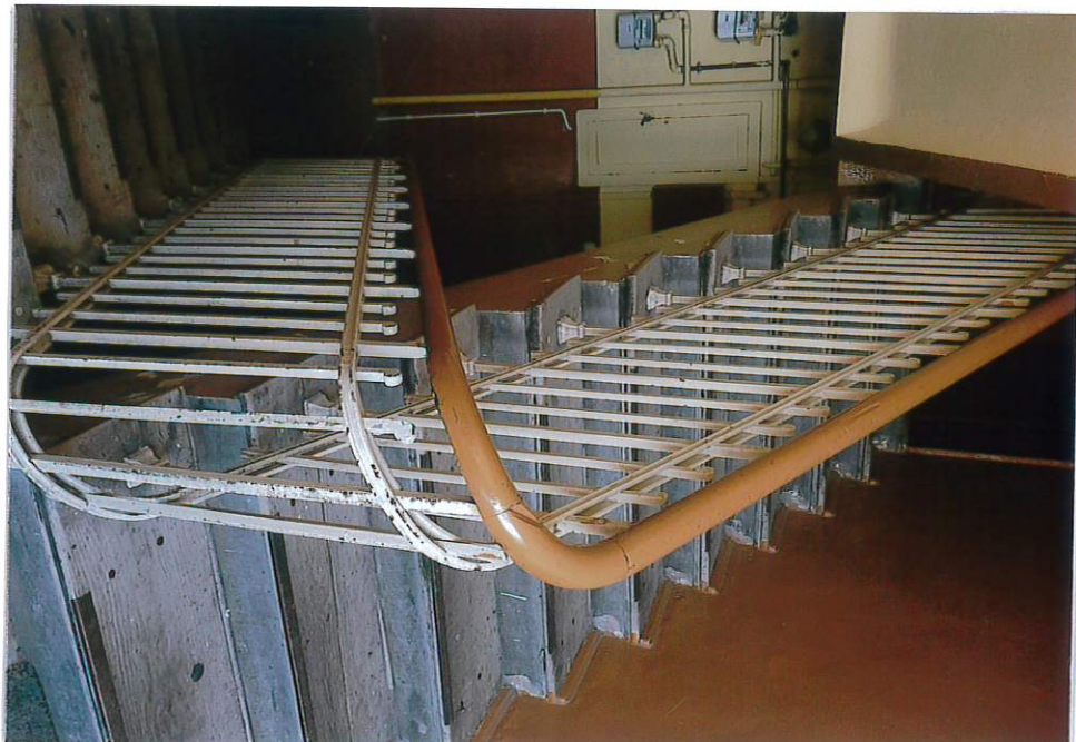
Fot. 9. Klatka schodowa
